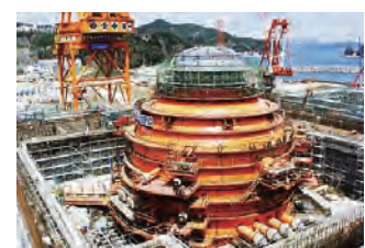
2号機の原子炉格納容器据え付け工事
