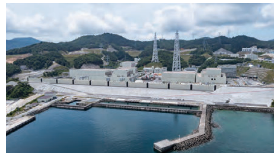
高さ海拔29m、全長約800mの防潮堤をはじめとする様々な安全対策工事を実施し、生まれ変わった女川原子力発電所
