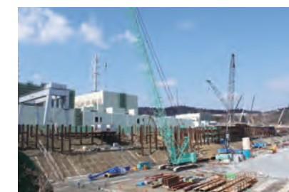
防潮堤建設の様子
