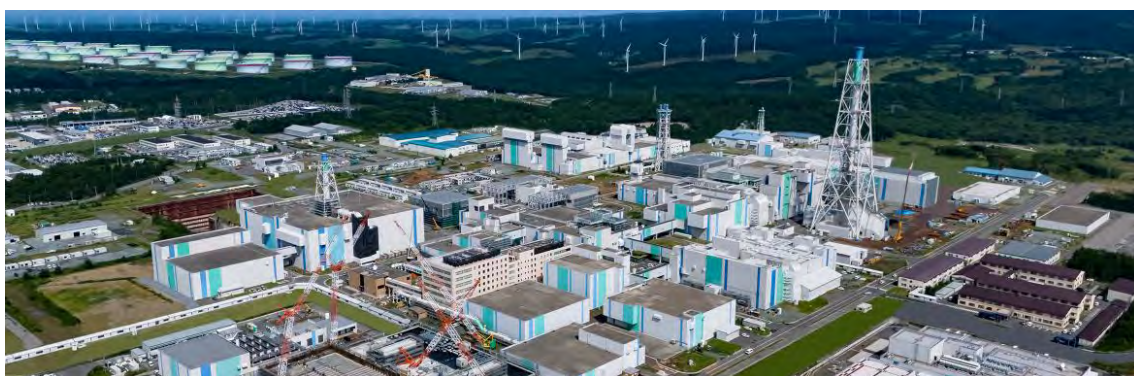
日本原燃株式会社の見学（上記画像は日本原燃ホームページより）
