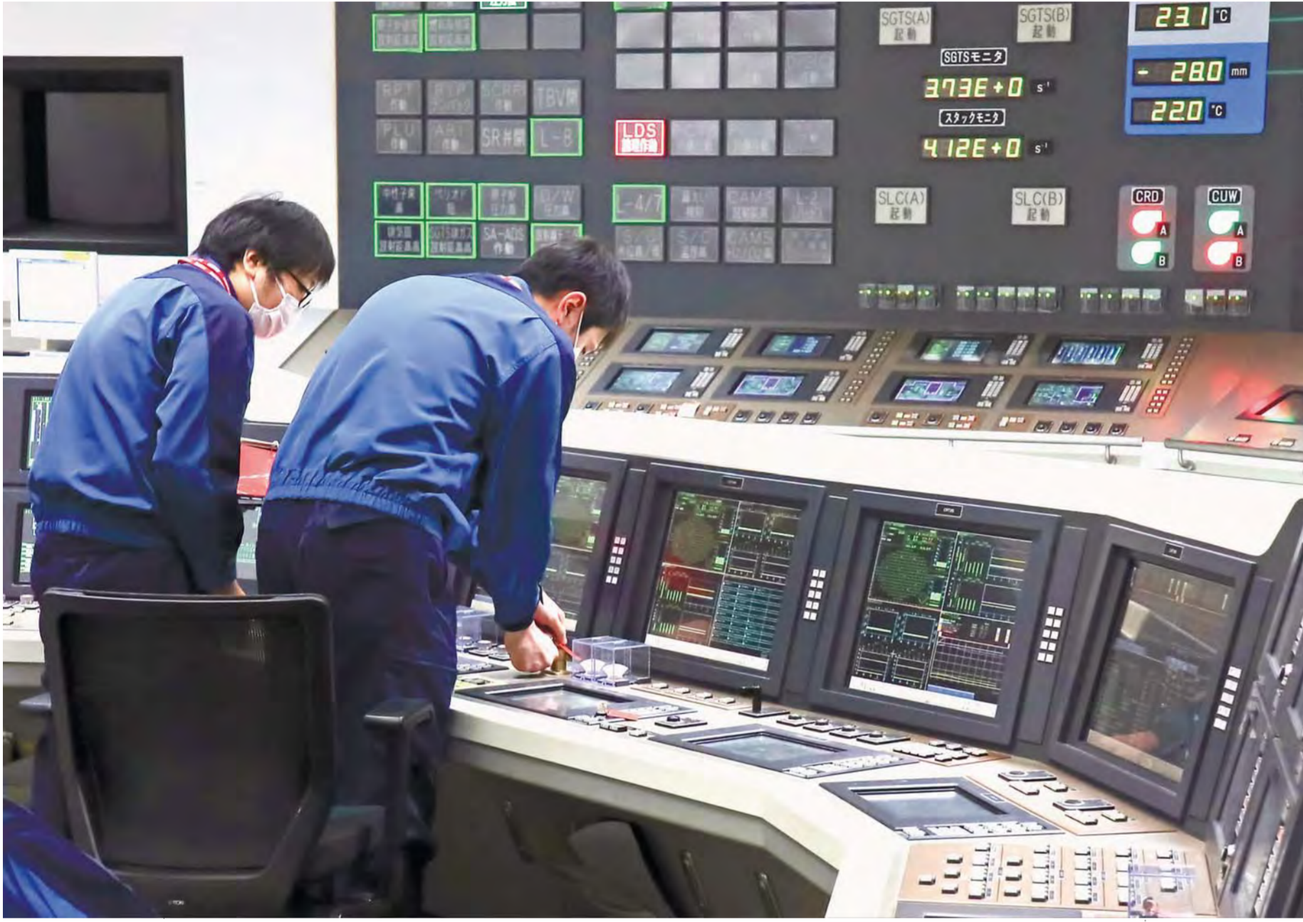
原子炉モードスイッチを起動に切り替える運転員 (写真は中央制御室、代表撮影)
