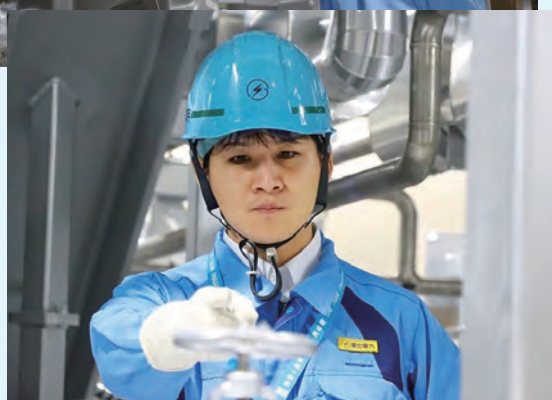
フィルタ付格納容器ベント装置(上)や配管(下)を確認する様子
