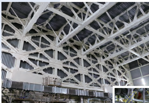
原子炉建屋の耐震補強工事
