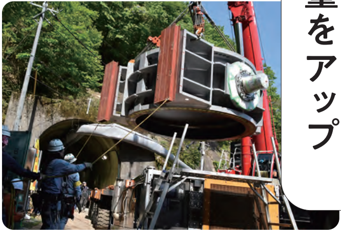
▲ 俣野川発電所の水圧鉄管弁取替工事
