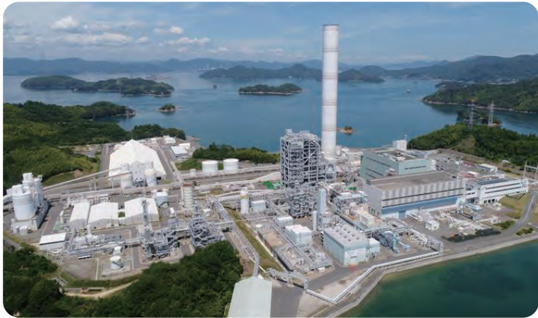
▲ 石炭ガス化複合発電の大崎クールジェン
