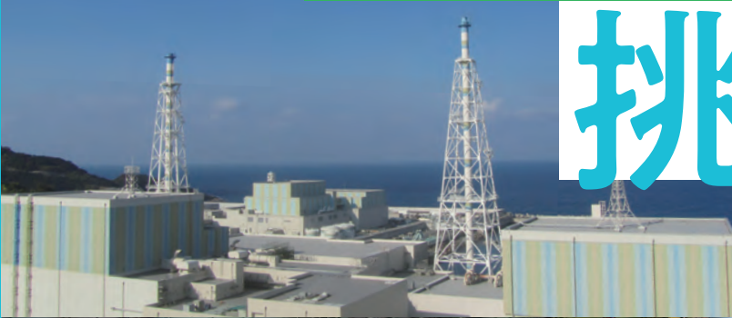
大型石炭火力発電所である三隅発電所のタービン
