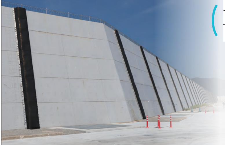
▼ 海拔15メートルある島根原子力発電所の防波壁
