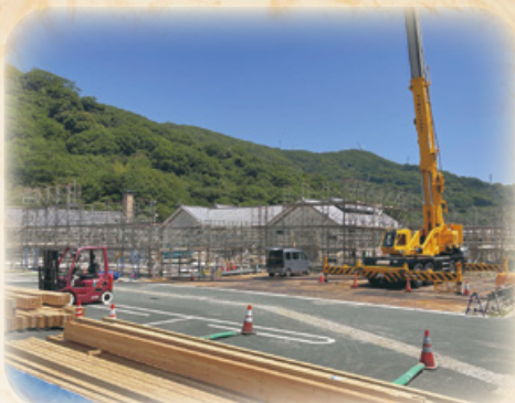
再建工事の様子
