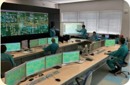
▲ 停電事故に備えて制御所システムを用いて訓練を実施
