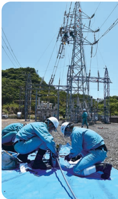
▲ 送電線の断線復旧訓練に取り組んだ
