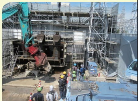
工事にはウォータージェット工法を採用 ▶
