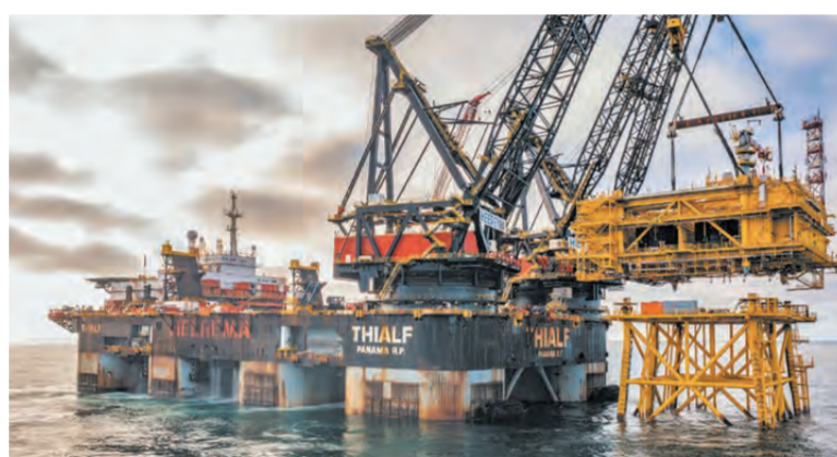
建設中の状況(開発事業者実施)
