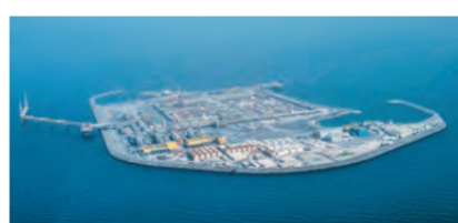
沖合にある石油・ガス生産基地
