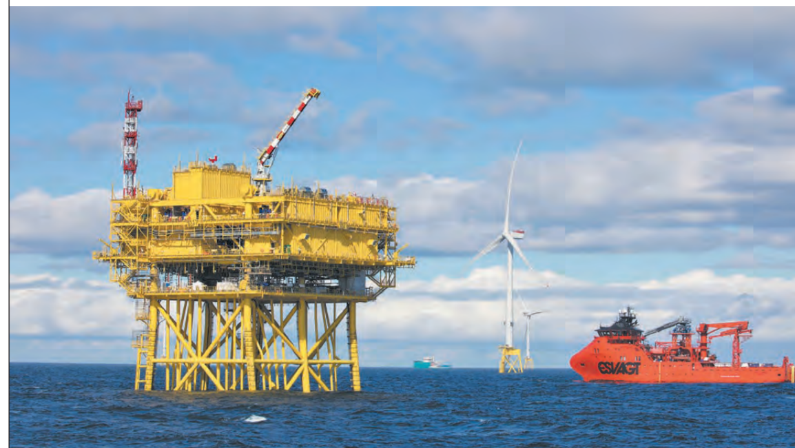
送電設備容量108万kw、ケーブル長約84kmの大規模送電設備を所有・運用する見通しだ
