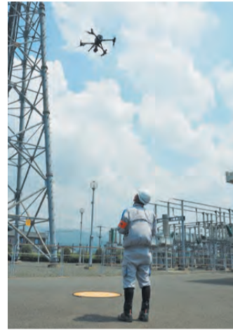
ドローンを用いた点検作業
