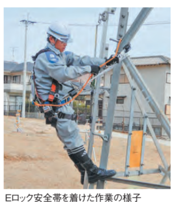
Eロック安全帯を着けた作業の様子
