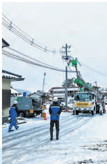
能登半島地震被災地で配電設備の復旧作業に臨んだ
