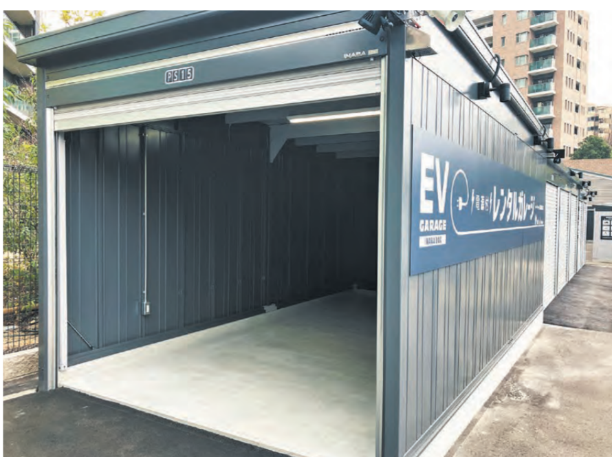
福岡市中央区薬院に設置したEVガレージ
