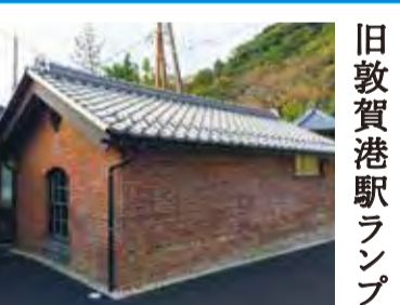
列車が灯火として使用するカンテラの燃料を保管する油庫として使用されていたが、光源が電灯に変わると急速に姿を消してしまいました。敦賀港駅のランプ小屋は丁寧に積み上げられたレンガや開口部のアーチに独特の趣があります。
