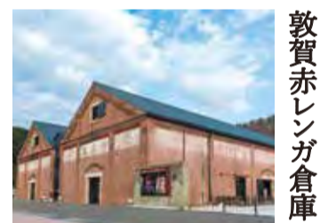
1905年に石油貯蔵倉庫として建設された、明治中期から昭和初期の敦賀港を象徴する建物で、国の文化財になっています。現在は北棟がジオラマ館、南棟がレストラン「館」になっており、歴史と文化と食を楽しむ観光施設となっています。
