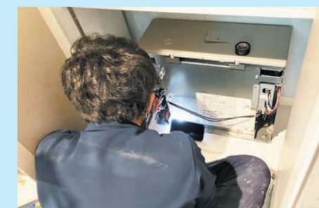
蓄電池設置工事の様子
