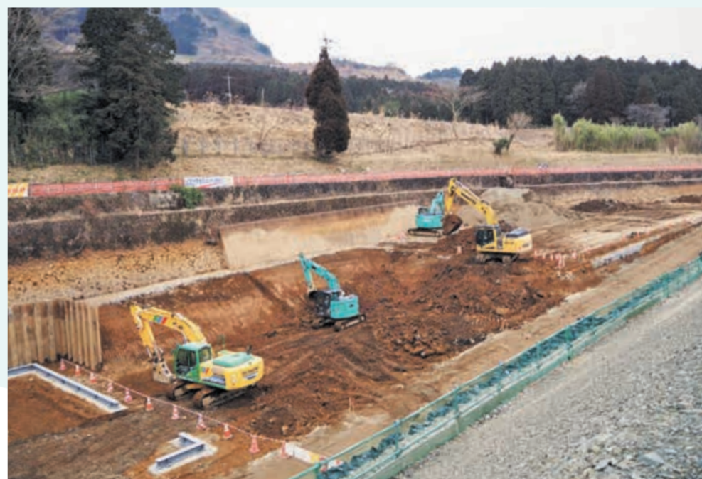
既設の沈砂池があった場所にヘッドタンクを新設する
