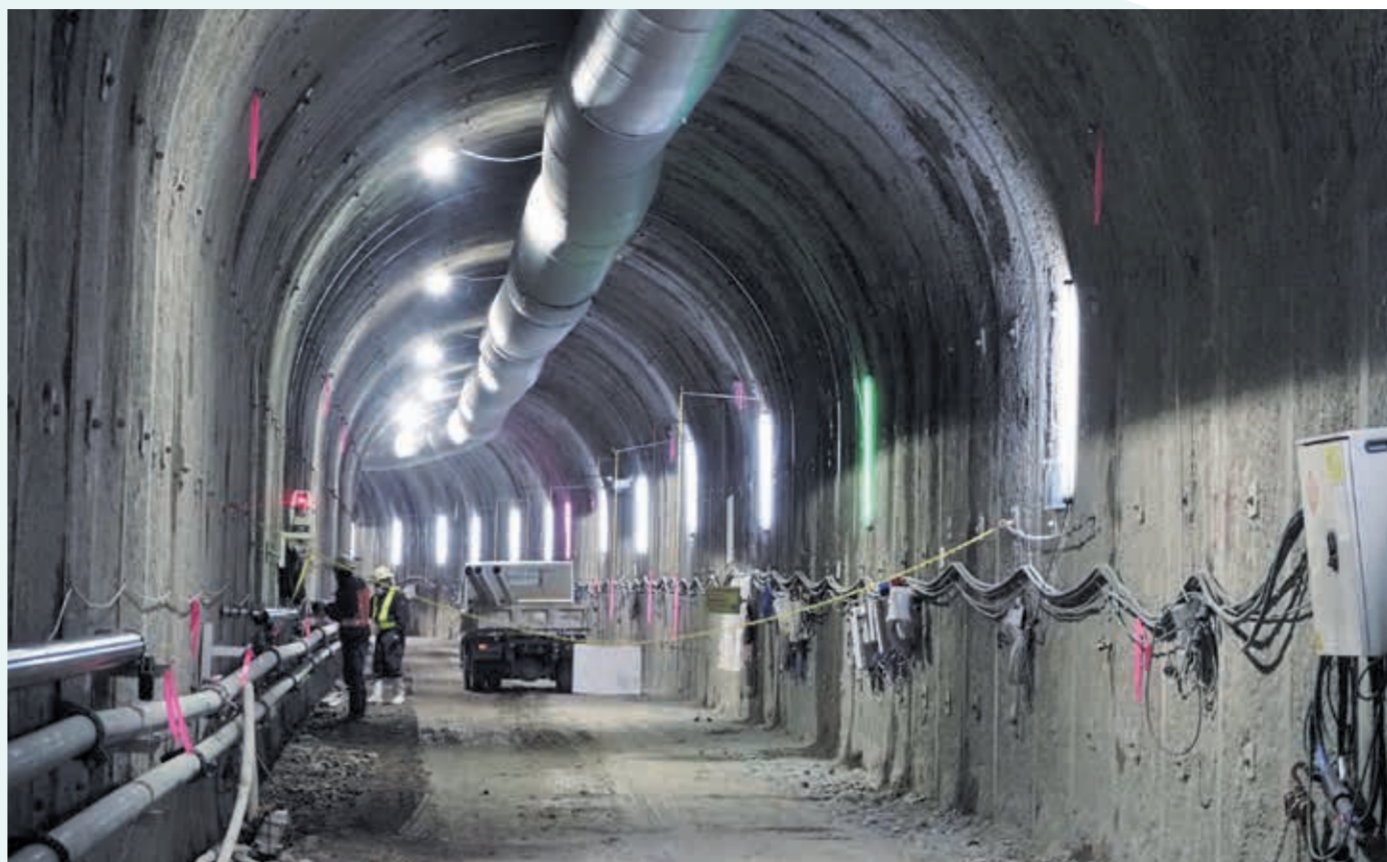
新たな水圧管路トンネルに向けて、作業用トンネルの掘削工事が順調に進んでいる
