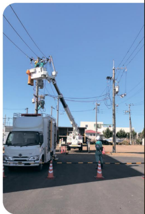
▶ 配電広域復旧課は様々な訓練に取り組んでいる(写真は仮送電訓練)
