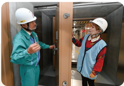
▲ 厚さ25センチメートルの水密扉で海水の浸入を防ぐ
