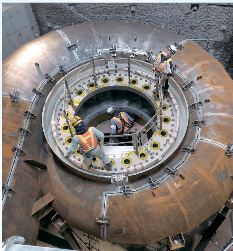
新竹田発電所で進む工事
