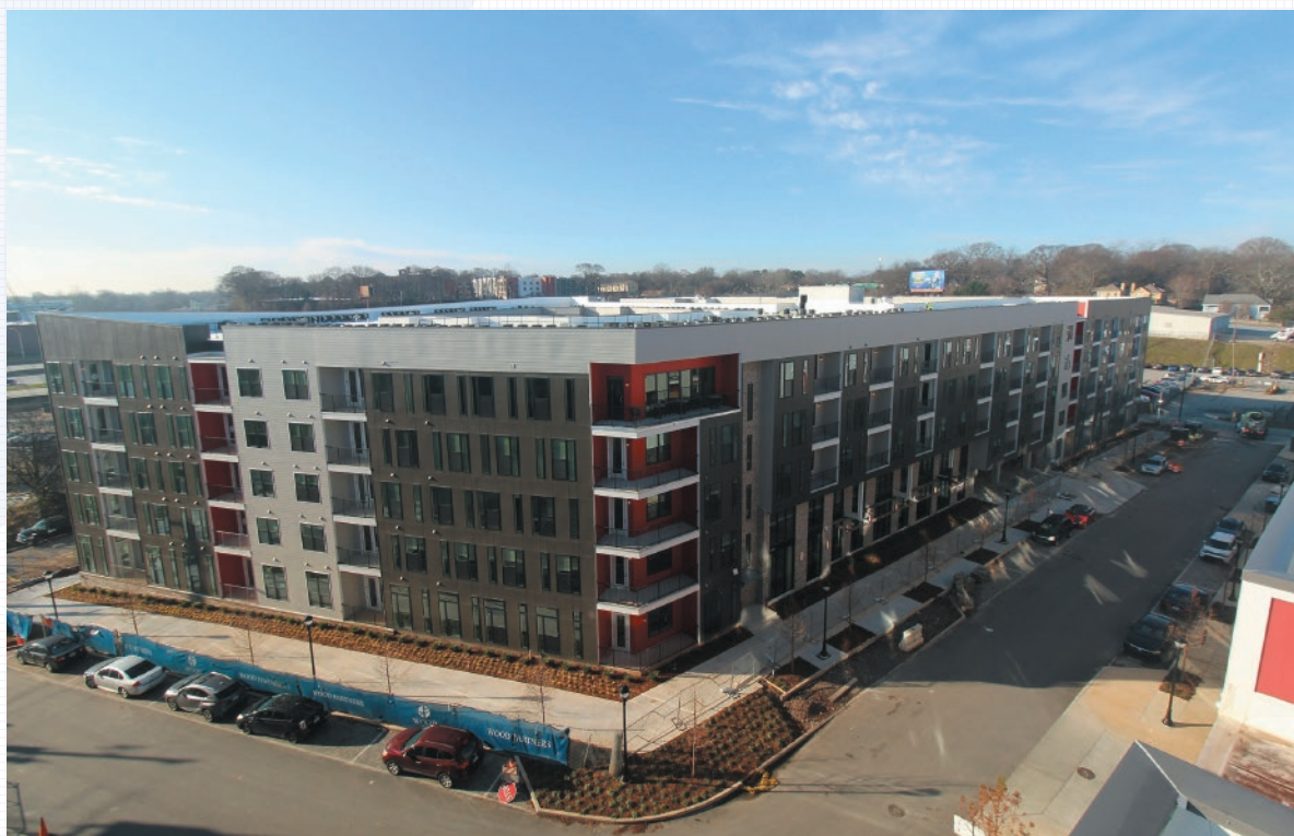
建設するマンションの外観
