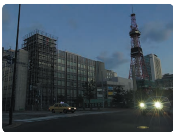
地震による影響で停電した札幌市内(2018年9月6日)
