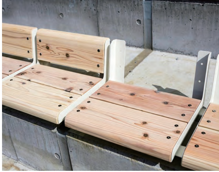
復興スタジアムに常設される座席。白い部分が、同社が製造した架台だ
