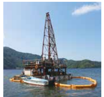
湖上でのボーリングの様子
