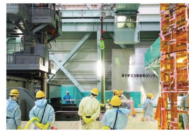
燃料プールで保管している新燃料(未使用)の除染作業
