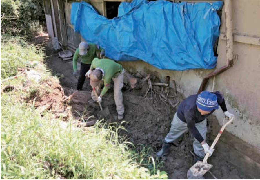
初日に行われた災害ボランティア活動。約5時間かけて土砂のかき出しなどの作業を完了させた
