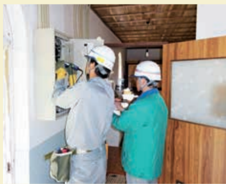
屋内配線の点検作業
