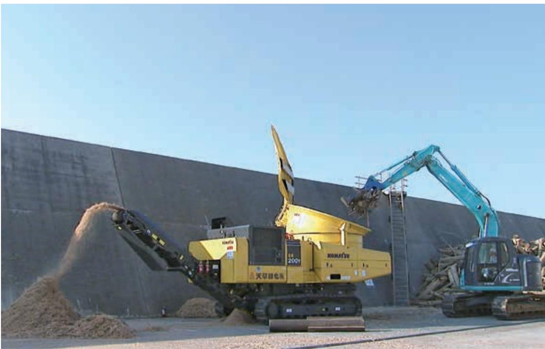
10月19日から発電所構内への流木の受け入れが開始された
