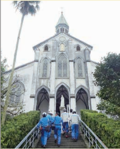
大浦天主堂をはじめ重要文化財の配線・避雷針点検を行った
