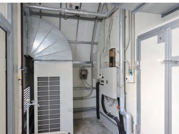
栽培舎内に設置されたヒートポンプエアコンの室外機
