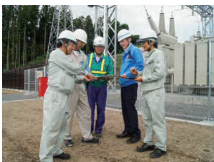
電力の安定供給に向け、打ち合わせを行っている様子。後ろに見えるのはコアテックが施工した特別高圧受電設備
