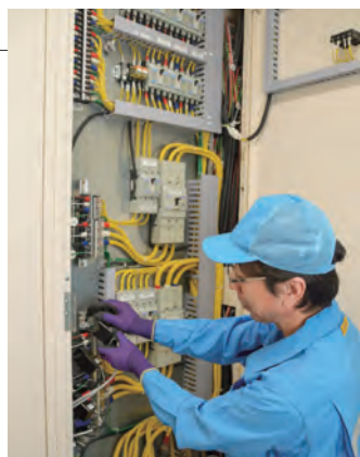
計測器の取り付け作業を行う石川さん
