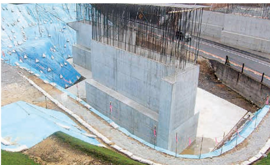
発熱抑制によるひび割れ防止のため橋脚にも活用されている
