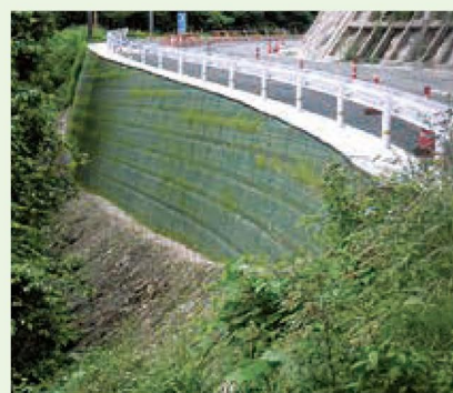
県道改良工事でもライトサンドが使われた
