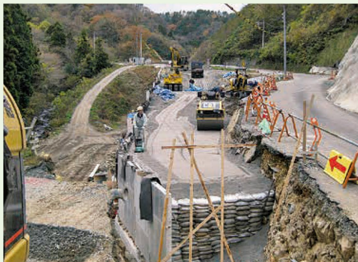
構造物への影響軽減のため、ライトサンドが採用された(島根県内)
