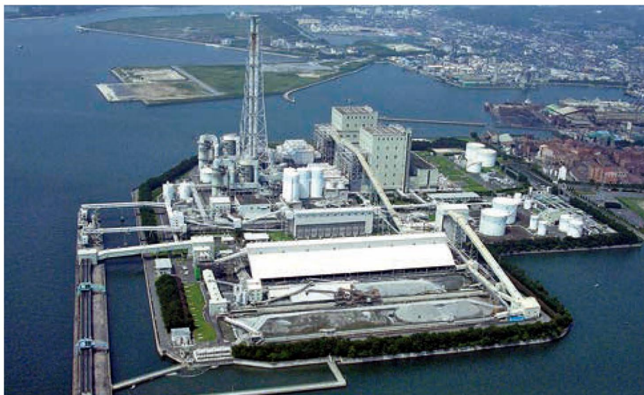
中国電力の新小野田発電所(山口県山陽小野田市)。合計出力100万kWの石炭火力として安定供給を支える
