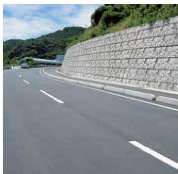
2次製品として道路側壁ブロックに採用
