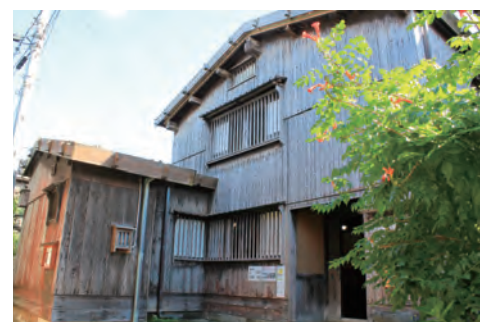
江戸時代後期から明治にかけて財を成した廻船主の邸宅「清九郎」は当時最高水準の木材や技術が使われています。現在は公開民家として見学可能です。千石船の船頭の屋敷「伊三郎」は、現在、一日一組限定の宿として営業しています。宿根木公会堂は、芝居小屋として今も多く行事に活用されています。
