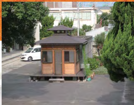
グリーンカーテンや雨水タンクまで備えたEcoハウス
