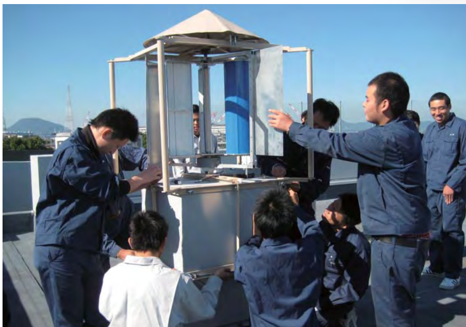
機械科と電気科生徒による風力発電機の取り付けの様子
